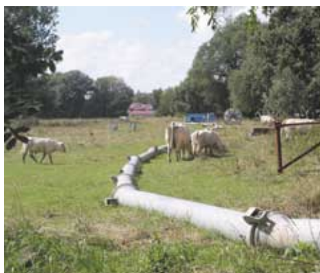
Le chantier du collecteur correspond à 1450 mètres de réseau (de l'ex usine Véramont à la station d'épuration). Du côté de la rue Hannong, le pompage provisoire ne semble pas perturber les vaches !
